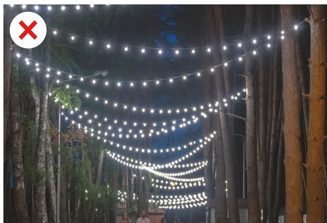
Пример неправильного крепежа гирлянд
