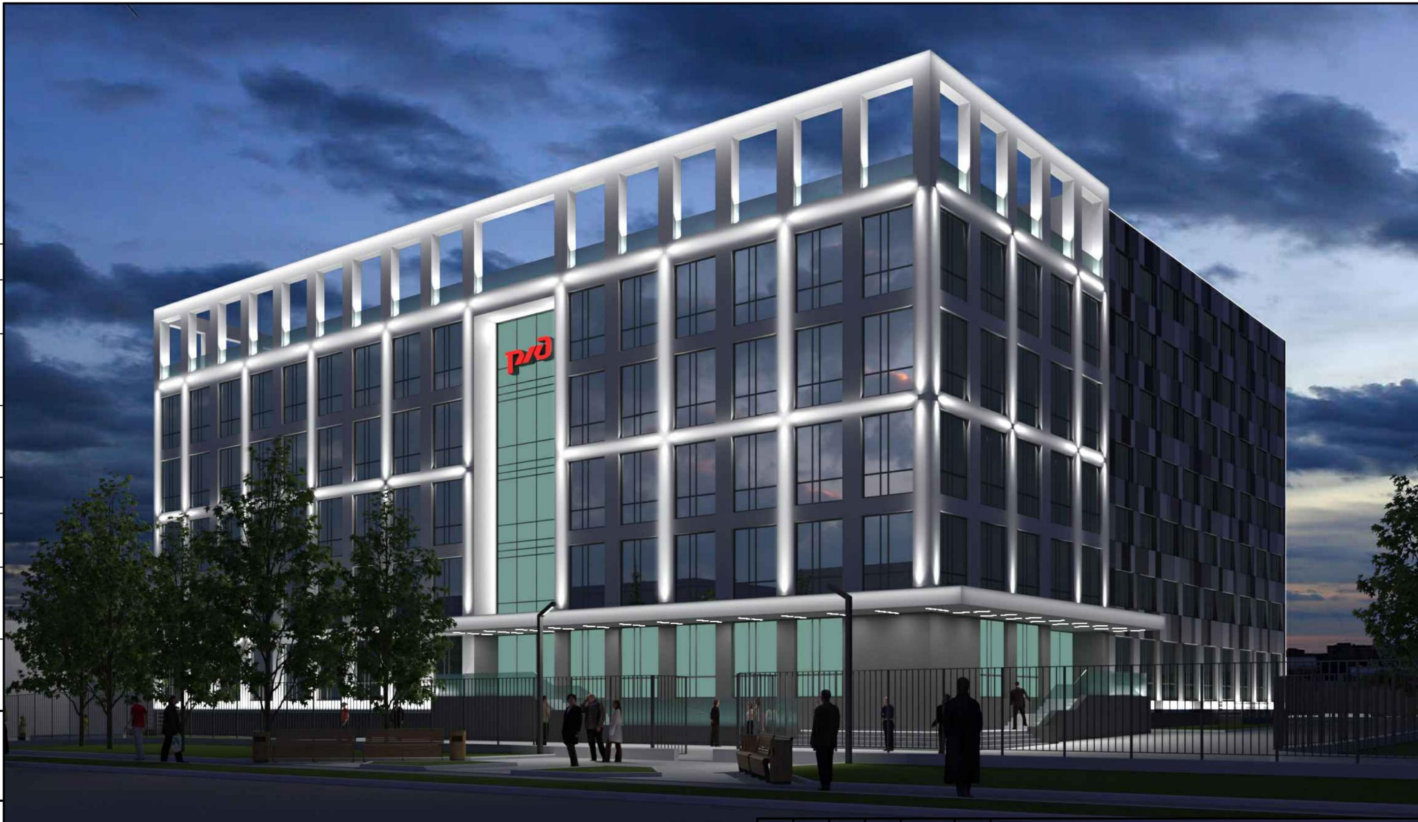
При проектировании использовано 2 типа светильников: светодиодные светильники линейные и однолучевые, выход света – однонаправленный, монохромный. Способ крепления: на стену, с регулировкой угла установки.
