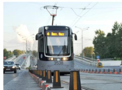
Обособление трамвайного полотна с помощью бортового камня и делиниаторов
